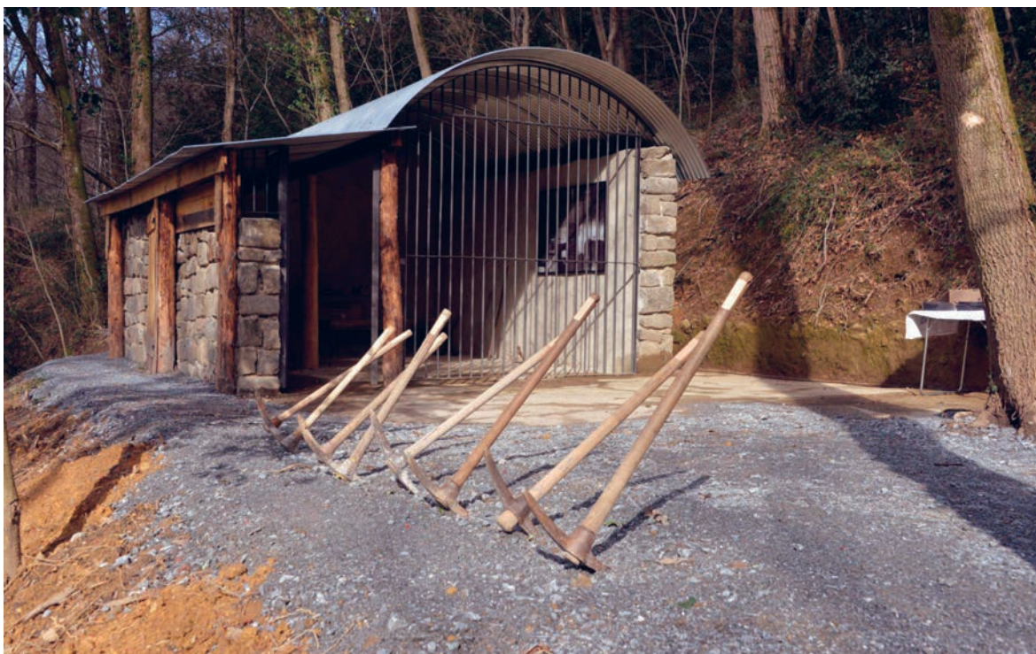
Arkaleko barrakoa, 8 trabajadoreak omentzen dituzten 8 pikotxak dituelarik aurrean.
